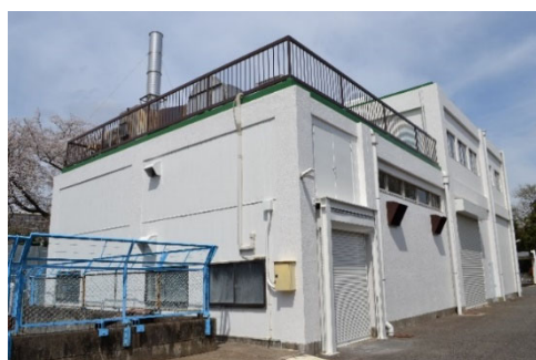
試験棟（修繕後）
